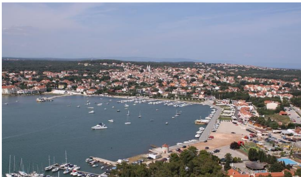
Slika 2. Pogled na izgrađenu jugoistočnu obalu zaljeva
